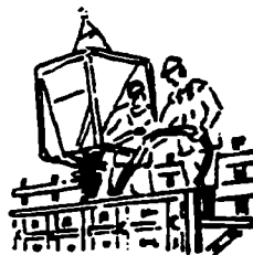
Udstøbning og vibrering 2 mand
