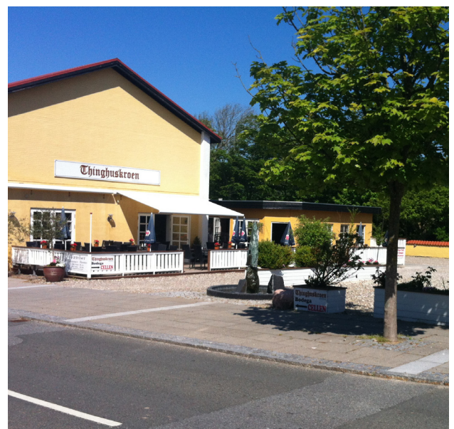
Byfornyelsen har skabt plads og rum til nye lokaler indendørs og til udeservering for Thinghuskroen i Vestervig. Et af LåsbySvendens faldefærdige huse lå tidligere lige ved siden af kroens gavl.
